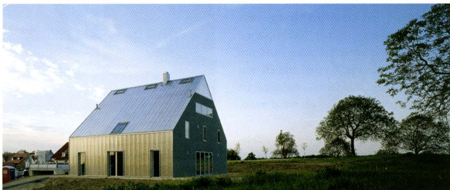
Die Form des Gebäudes orientiert sich an der klassischen Bautradition vor Ort
