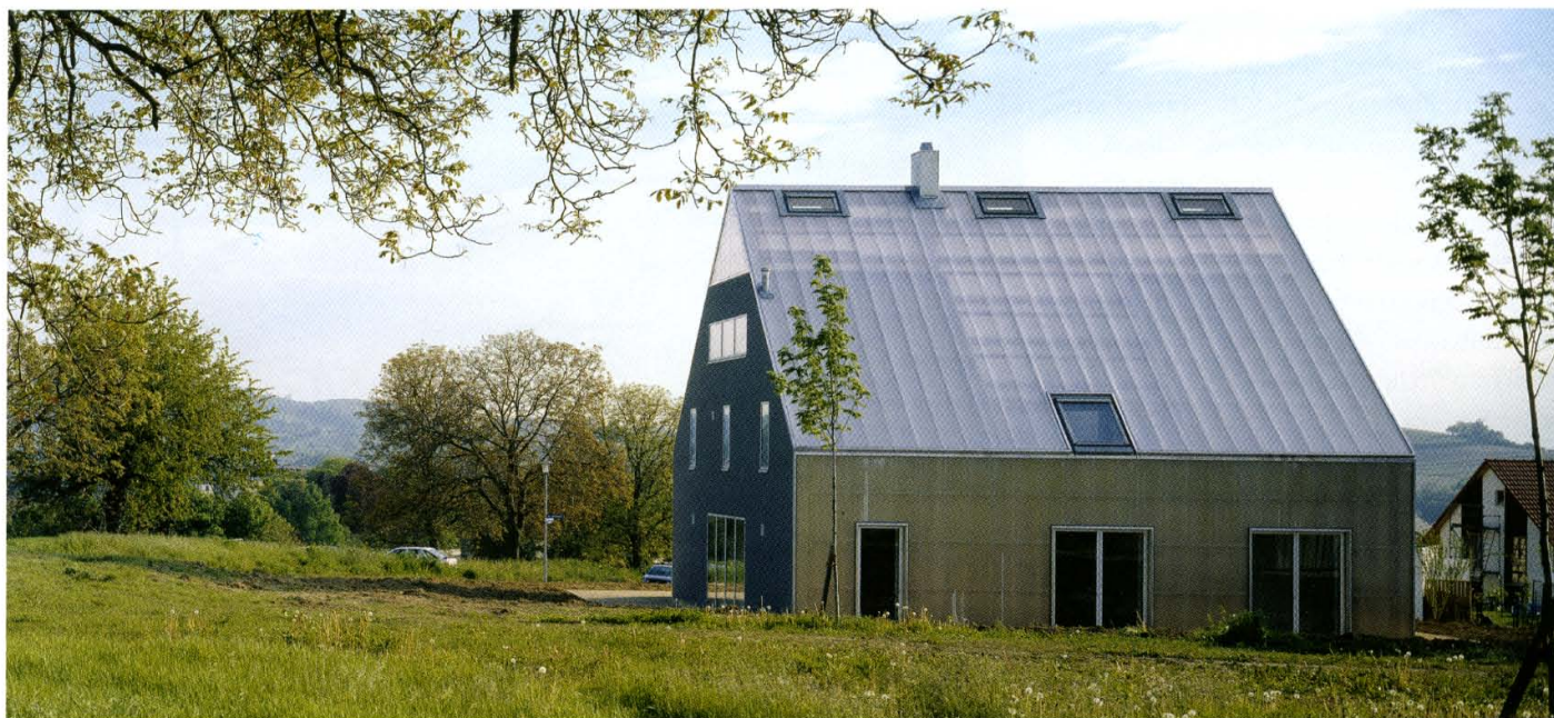
Die Dach- und Wandflächen auf der West- und Ostseite sind mit Polycarbonatplatten verkleidet. Sie erfüllen die Funktion eines Luftkollektors
