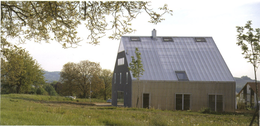
Abb. 4: Patchworkhaus in Mülheim/Baden 2006. Kombination/Energiegarten – Speichermassen.
