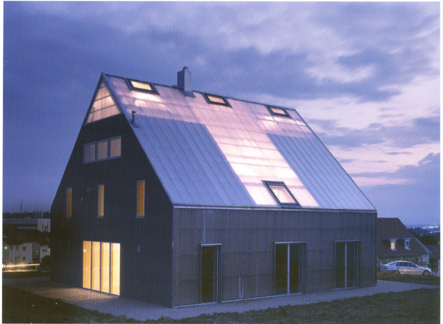
Abb. 5: Patchworkhaus in Mülheim/ Baden 2006. Kombination/Energiegarten – Speichermassen.
