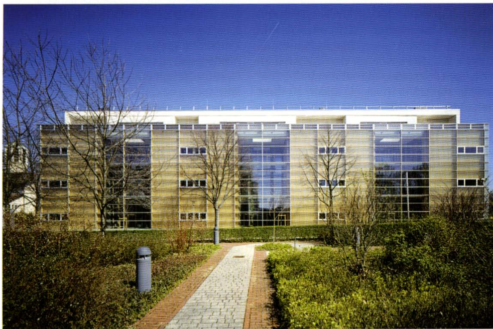
Abb.6 Institut für Umweltmedizin und Krankenhaushygiene, Freiburg 2003-2006, frontale Ansicht Fig.6 Istituto di Medicina Ambientale e Igiene Ospedaliera, Friburgo 2003-2006, Vista frontale
