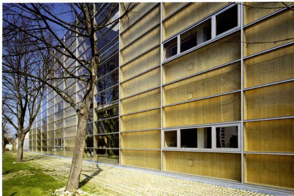
Abb. 7 Institut für Umweltmedizin und Krankenhaushygiene, Freiburg 2003-2006, perspektivische Ansicht der Fassade
