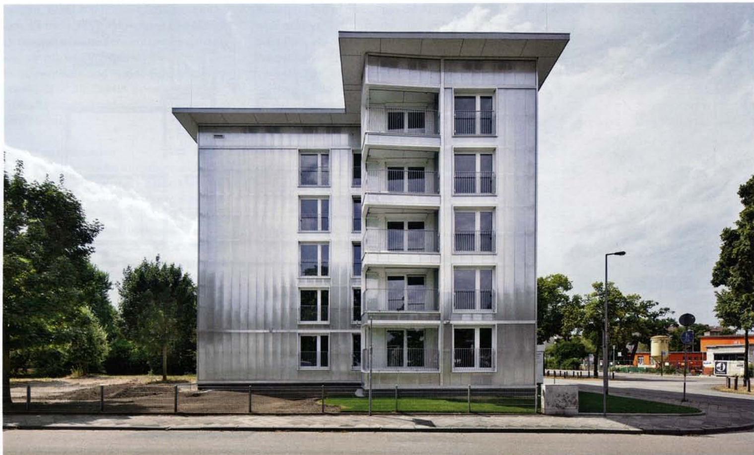
Für die transluzente Hülle verwendeten die Architekten 9-Kammer-Polycarbonatplatten mit einem U-Wert von 0,83 W/m 2 K
