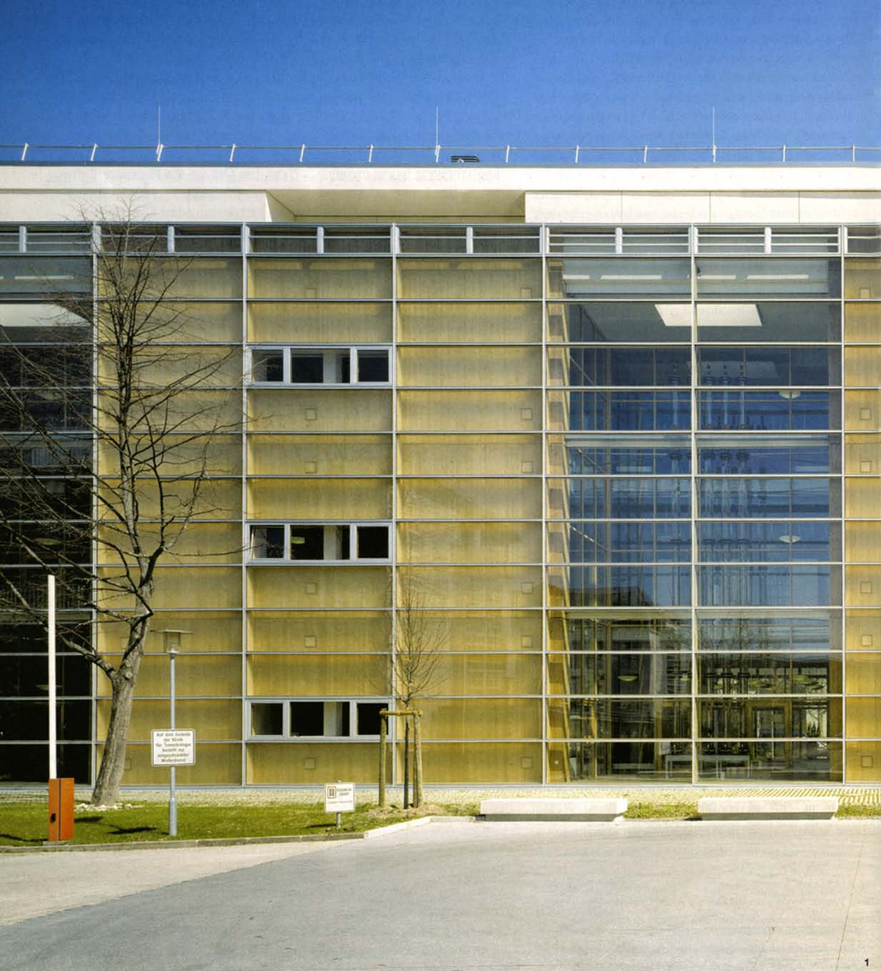
1 Institut für Umweltmedizin und Krankenhaushygiene der Universität Freiburg ist ein von pfeifer. kuhn. architekten freiburg (bis 30. 6. 2005 pfeifer-roser-kuhn) nach dem kybernetischen Prinzip geplantes und realisiertes Gebäude. Auf der Südseite mit einem dreigeschossigen Luftkollektor ausgestattet im Verbund mit einem geothermischen Erdregister und Bauteilaktivierung funktioniert die Klimatisierung der Büroteile auf der Basis natürlicher Lüftung ohne technische Hilfsmittel. The Institute for Environmental Medicine and Hospital Hygiene of the University of Freiburg is a building that was planned implemented to the cybernetics principle by pfeifer. kuhn. architects freiburg (formerly pfeifer-roser-kuhn until 30. 6. 2005). Equipped with a three-storey air collector on the south side, connected with a geothermic earth-tube collector and thermo-active building systems, the air conditioning in the administration wing functions on the basis of natural ventilation without technical support. Foto photo: © Ruedi Walti, Basel
